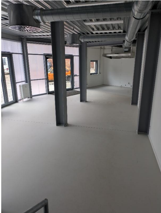
Blick in den Gastraum (Zugang vom Foyer)
