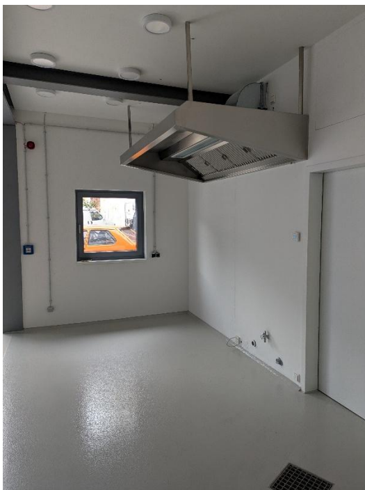
Blick in den Ausgabebereich
